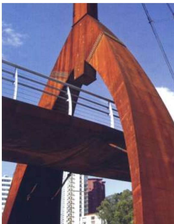
Figura 2. Arco de ponte revestido com chapas de aços patináveis. (CBCA)
